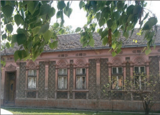
Ehemaliges Gasthaus in der Hauptstraße von Futok, 2014
